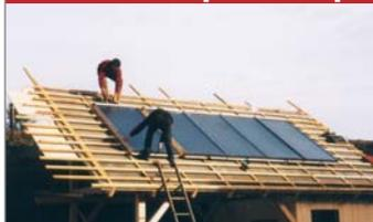
Captador solar para la instalación en el tejado rápida y fácil; ecológico marco de madera para la armónica integración en la cubierta, absorbedor de cobre con recubrimiento de alta selectividad para el aprovechamiento óptimo de la energía solar.
